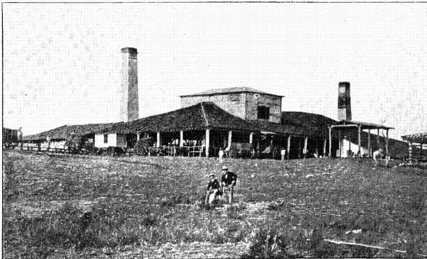
Abb. 12. Fabrikgebäude eines Ingenio.
